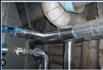
Bitumen gyár szigetelés (S&L)
